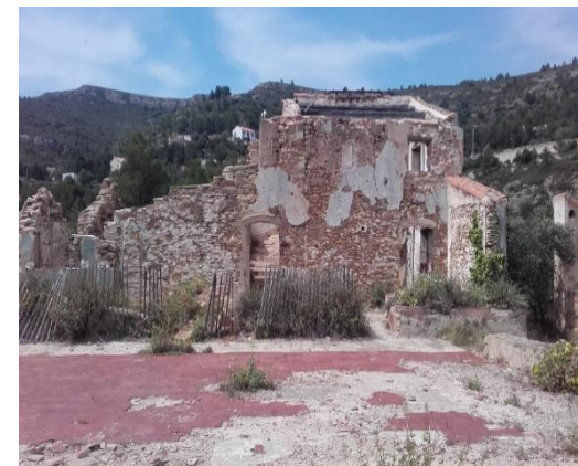
Mise en sécurité de la villa Speany, sur le site de Sainte Frétouse
