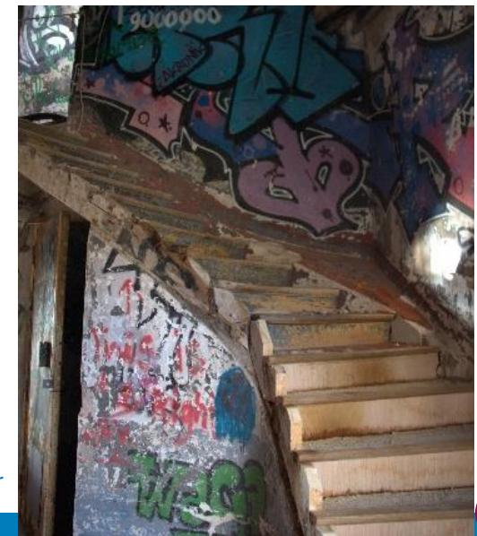
Restauration de l'escalier intérieur
