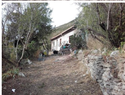
Démolition de la maison Khoury (avant/ après)
