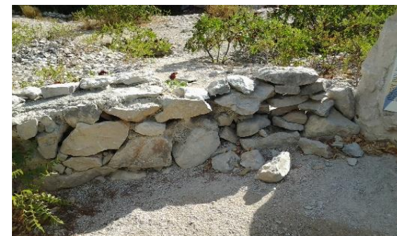
Reconstruction de murets sur la presqu'île de Port-Miou
