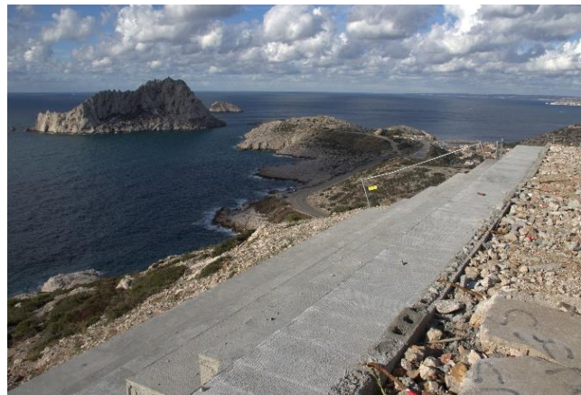
Construction de gradins
